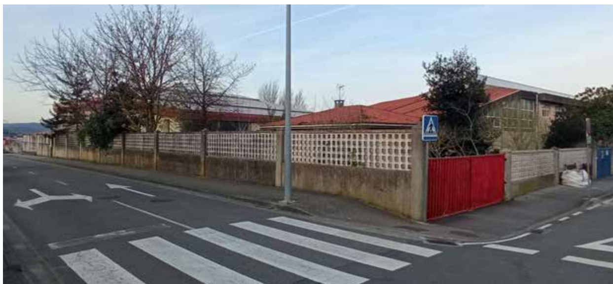
Imaxe 2. Muro na Rúa Anduriñas
